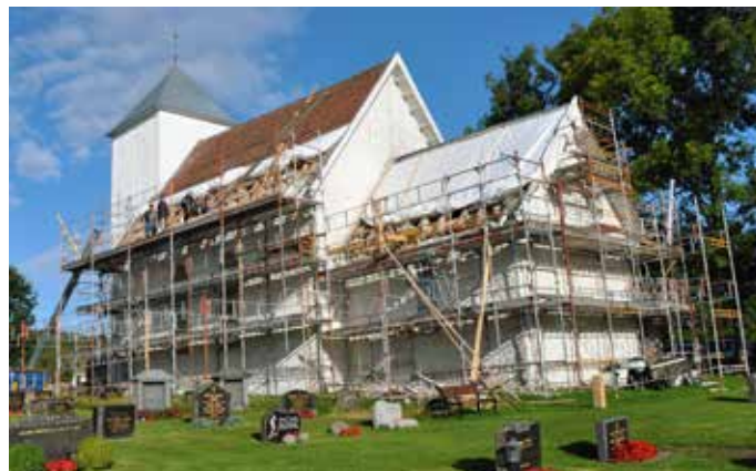
Arbeidene i gang med utskifting av tak på Fon kirke.
